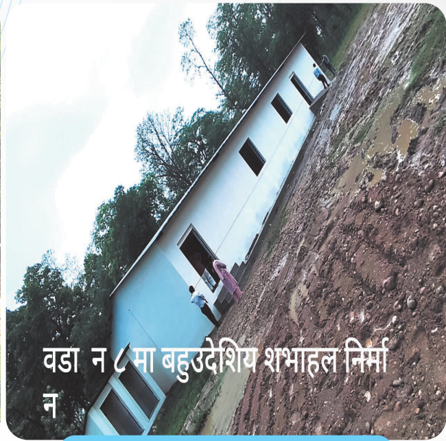
वडा ८ सम्शेरगंजमा सभाहल भवन निर्माण
