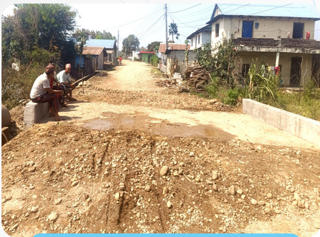
रुद्र थापाको घर नजिक कल्भर्ट निर्माण, वडा नं. ८
